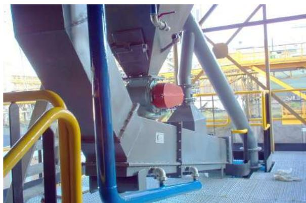
Le transport pneumatique est le fait de transporter un produit solide en utilisant un gaz (généralement de l'air) comme vecteur.
